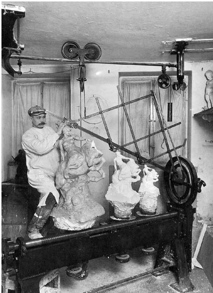
3 Einsatz eines Pantografen in der Berliner Bild- gießerei Noack um 1912
